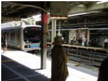
山手線の隣に移設した埼京線ホーム
