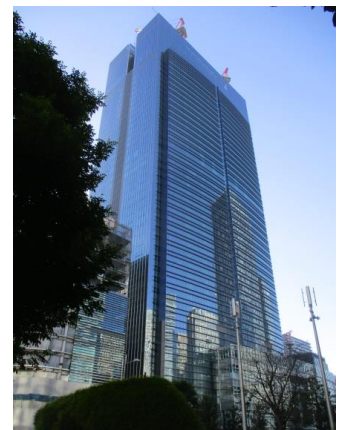
建設中の八重洲ミッドタウン(11月25日撮影)
